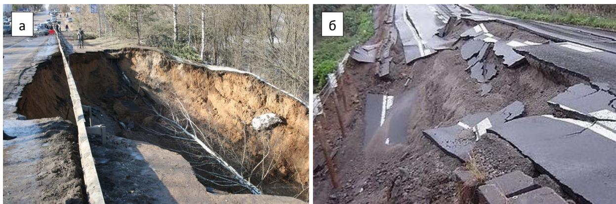
Рис. 1. Оползание откоса в виде провала (а) и прямолинейной (б) поверхности
