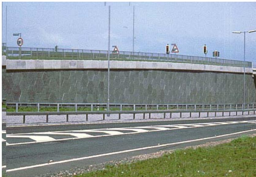
Рисунок 8 – Армогрунтовая стенка с облицовкой из шестигранных бетонных блоков
