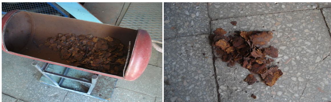
Рис. 1. Внутренняя поверхность и загрязнения газового баллона объемом 50 литров после 5 лет эксплуатации
