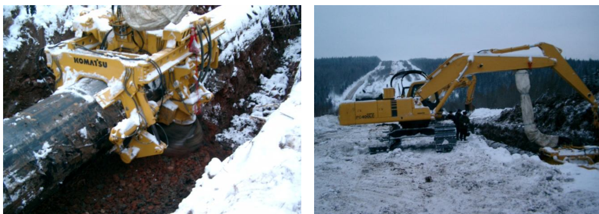
Рис. 9. Подкапывание трубопровода
