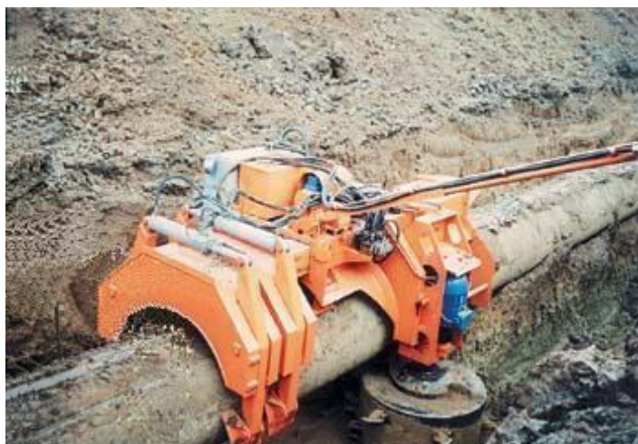
Рис. 3. Подкапывание трубопровода
