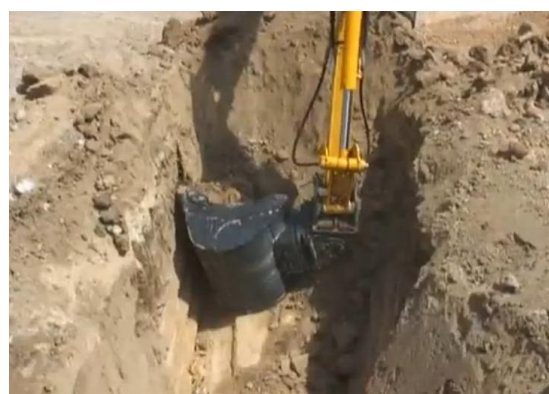
Рис. 7. Ковш с поворотным соединением
