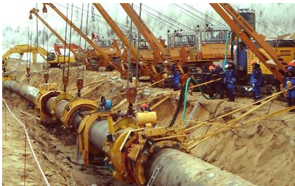
Рис. 5. Ремонтно-строительная колонна
