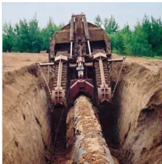
Рис. 2. Вскрытие магистрального трубопровода
