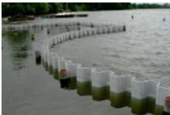
Рис. 4. Шпунтовое ограждение водоёма
