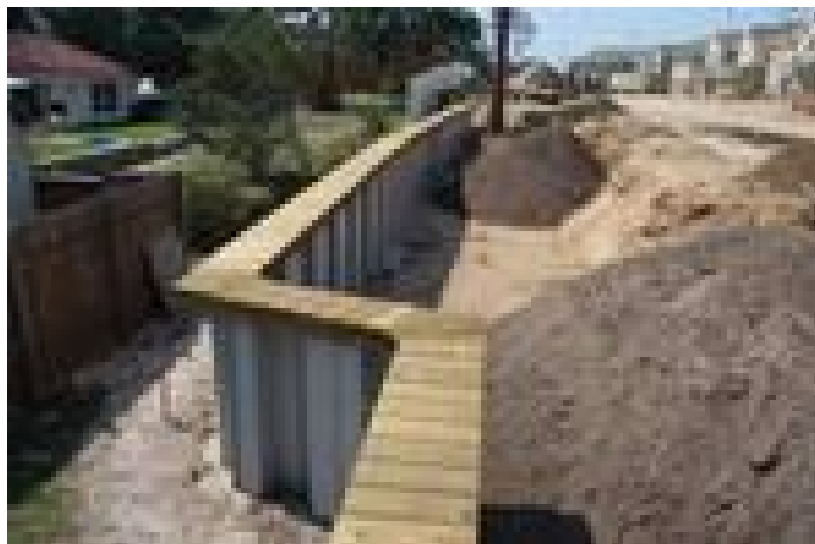
Рис. 7. Использование шпунт ПВХ при стабилизации автодорожной насыпи
