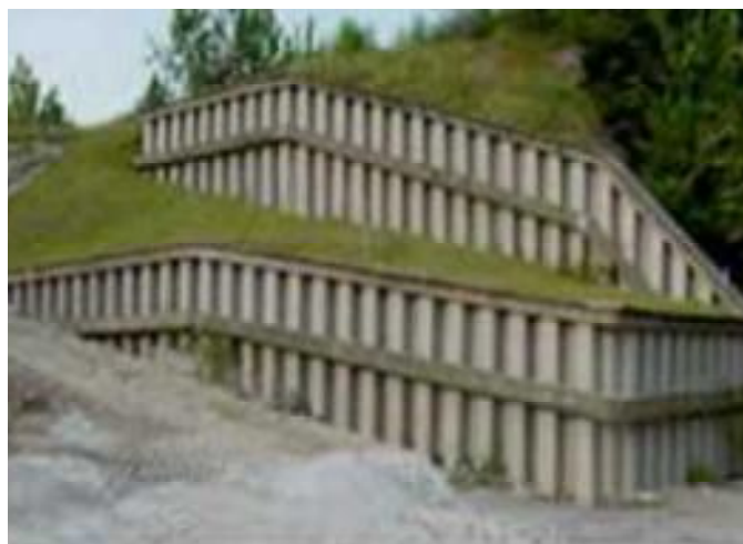
Рис.6. Строительство опорных стен террасным способом с использованием шпунта из ПВХ
