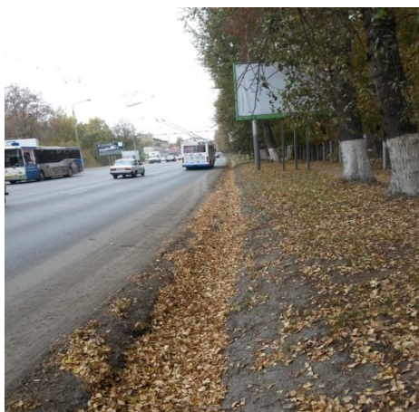
Рис. 3. Состояние водоотводной канавы в зависимости от сезона
