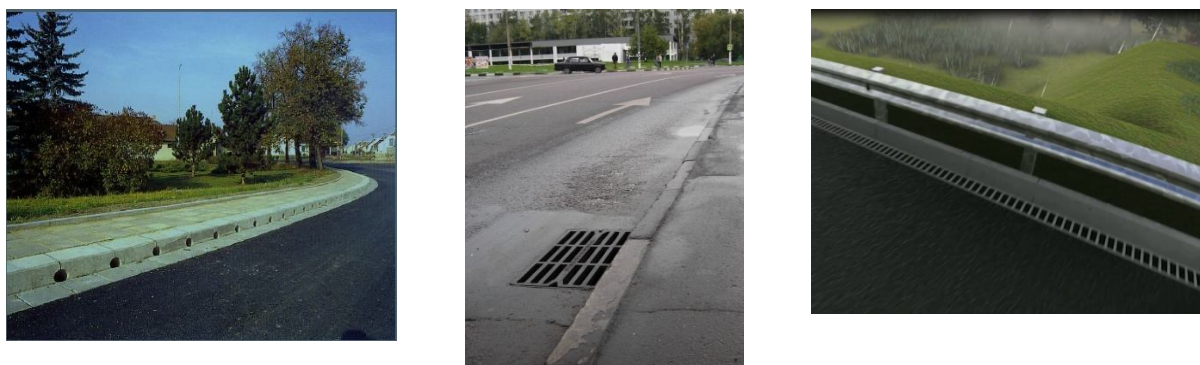
Рис. 6. Водоотвод закрытого типа
