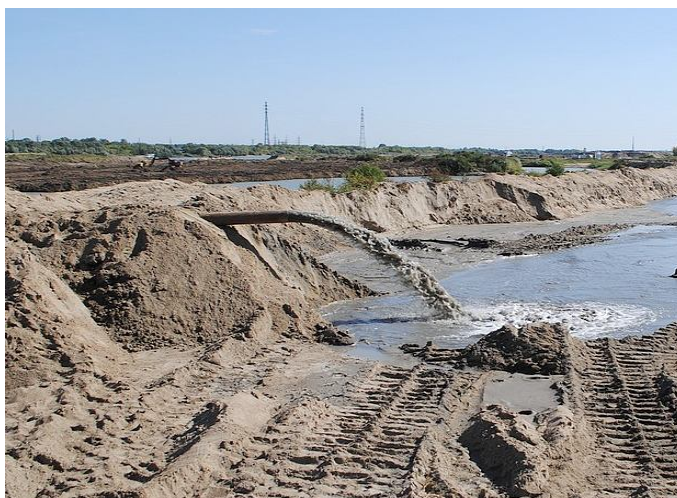
Рис.1. Формирование карты намыва безэстакадным методом
