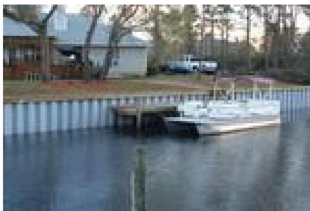
Рис. 8. Причальная стена из шпунта ПВХ
