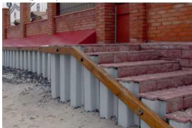
Рис.2. Применение шпунта из ПВХ в коттеджном строительстве
