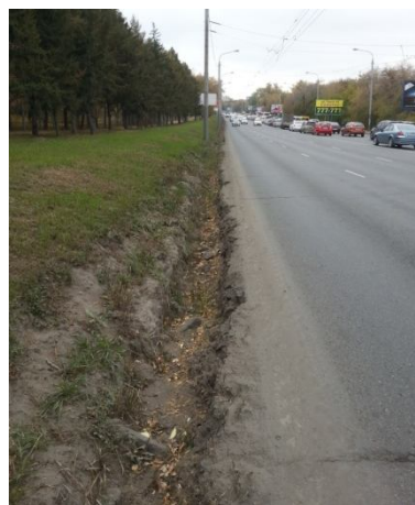
Рис. 4. Состояние водоотводной канавы (сентябрь 2014 г.)
