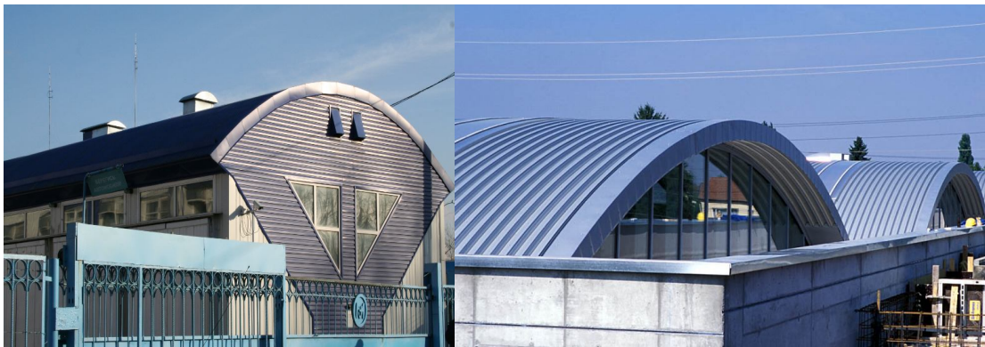
Рисунок 2 - Пример арочного несущего покрытия общественных зданий
