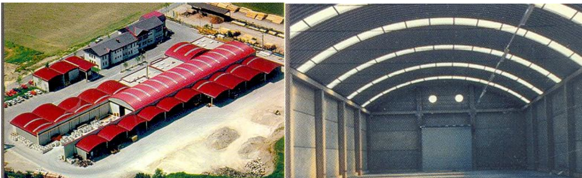
Рисунок 4 - Пример арочного несущего покрытия промышленных сооружений
