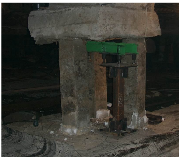
Рисунок 1 - Подготовка свайного фундамента к усилению
