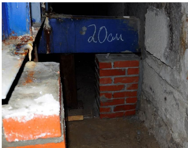
Рисунок 2 - Непроектное опирание балок бассейна на фундамент торцевой стены здания
