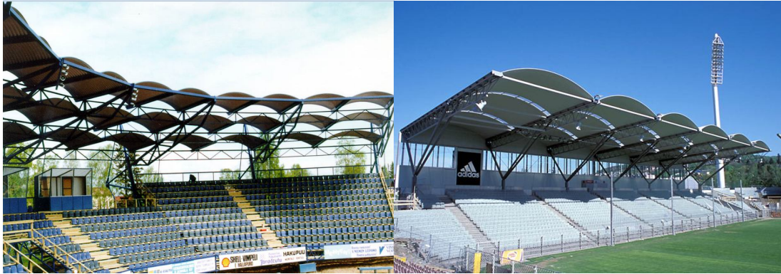
Рисунок 1 - Пример арочного несущего покрытия спортивных сооружений
