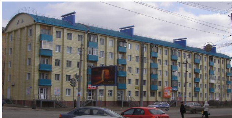
Рисунок 3 - Пример арочного несущего покрытия жилого здания
