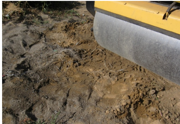
Рис. 4.23 – Вибрационный каток ДУ-107 над областью среды с датчиками
